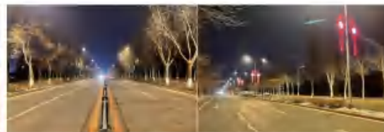
图4 城市次干路-长春市高新区道路照明 提升工程项目
