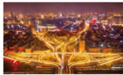
图6 城市立交桥照明-长春市朝阳区西解放 立交桥单光源LED高杆灯改造项目
