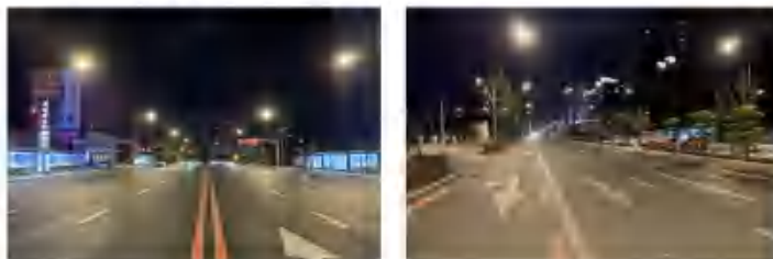
图1 长春主干路-长春市解放大路，吉林大路照明提升工程项目
